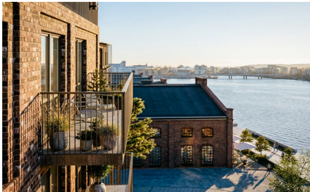
Direkt framför huset byggs det en park med öppna ytor, lektytor, sittgrupper och en brygga.
